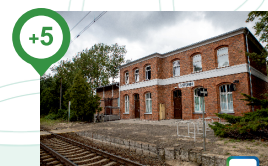
Stacja kolejowa w Antoninie
